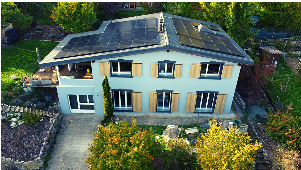
Maison pilote à Montezillon, dans le canton de Neuchâtel. (©PixByFlix)
